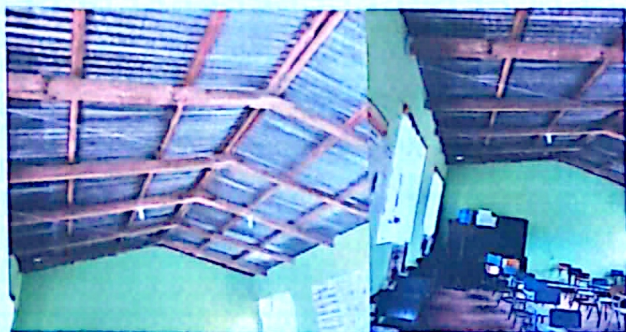
Foto1: Estructura DE Techo, de tres aulas se coloca el cielo falso
