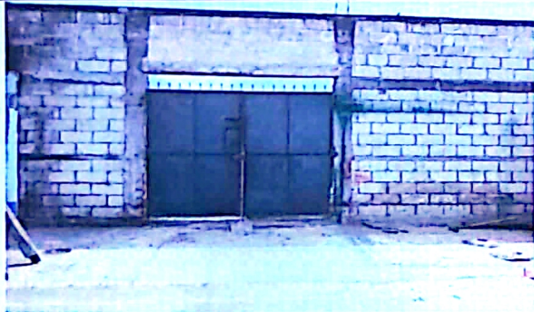
Foto 3: Cambio de1 portón grande del perímetro de la escuela y colcación de una cabaña en la parte de arriba.
