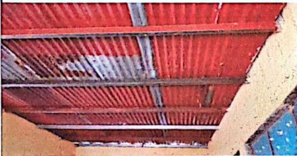
Foto 3: Cambio de Techado por goteo del aula de quinto B
