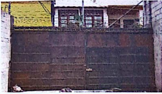
Foto 1: Levantado de Muro perimetral
