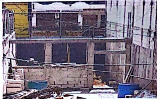
Foto 2: Levantado de Techo del aula de Segundo B
