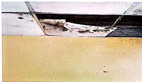
Foto 6: cielo falso dañado, por infiltración de agua de lluvia en una de las aulas.
