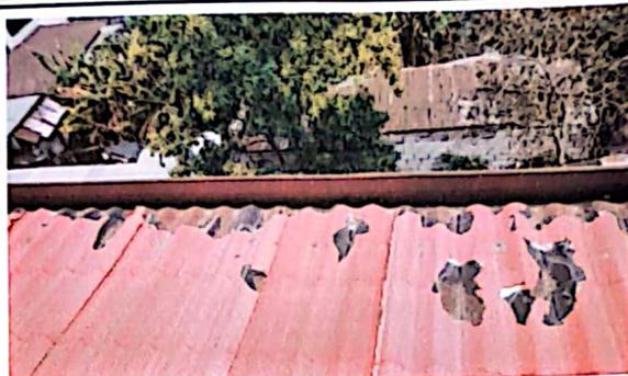
Foto 2: Techo y canal , en la cual se infiltra el agua en tiempo de lluvia.
