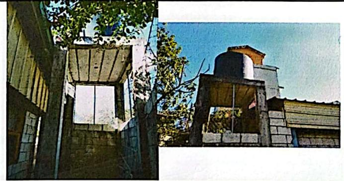
Foto 6: Depósito de agua potable. Donde se sacará las nuevas instalaciones de tuberías para la cocina.
