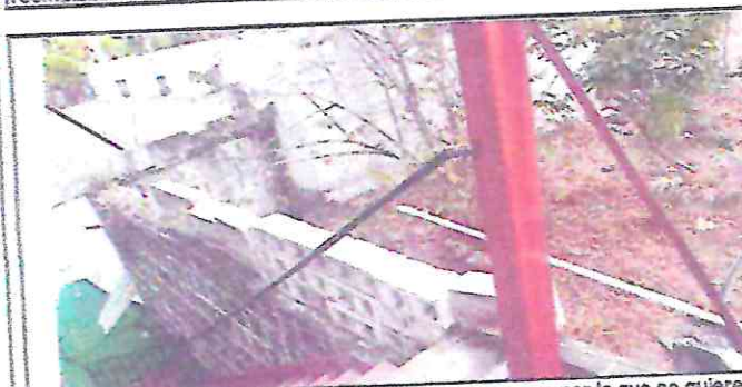
En su anterioridad había entrado ladrones por ese muro por lo que se quiere levantar 175 centímetros con block, para evitar la entrada de personas indeseadas en la escuela.
