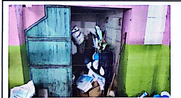
Foto 3: Instalación de puerta de bodega.
