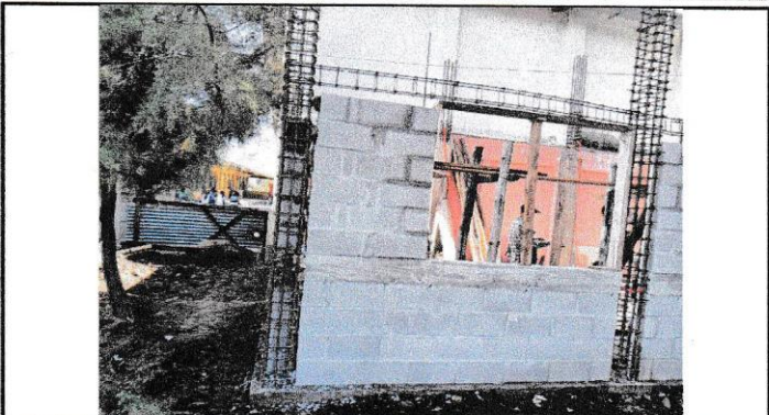
Foto 2: Ampliación de la Cocina ya con pared construido y posteriormente remodelado.
