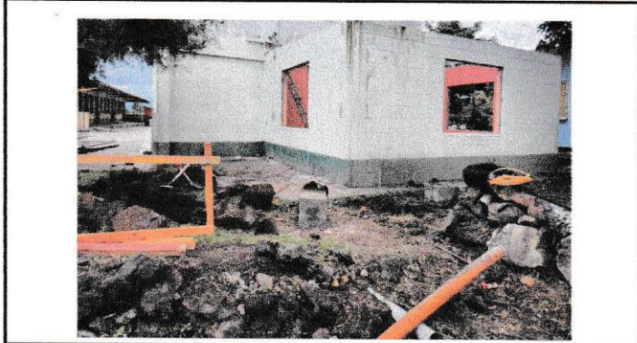
Foto 1: En proceso de colocacion de la columna para la ampliacion
