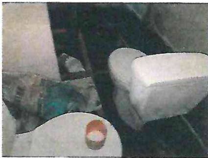
Foto 3: Instalación de sanitarios primer Nivel
