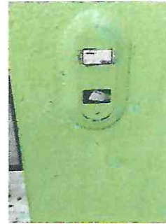
Foto 2: Instalación eléctrica primer nivel
