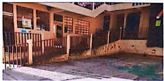
Foto 2: mantenimiento de barrandas
