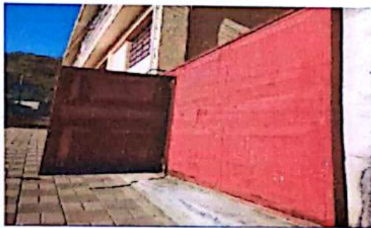
Foto 3: mantenimiento a portones
