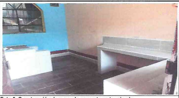
Foto 5. Construcción de mesa de concreto ya terminado.
