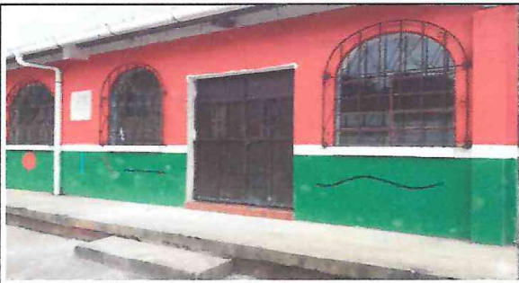
Foto 3. modificacion de puertas por altura del dintel, terminado.
