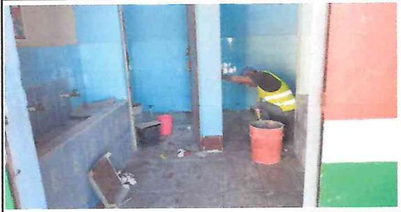
Foto 4. levantado de inodoro existente para colocación de ceramico
