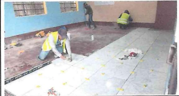
Foto 2. Colocaion de piso ceramico, y colocacion de zocalo
