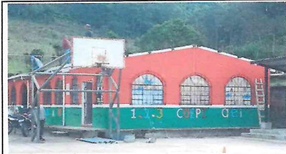
Foto 1. Cambio de lamina por lamina troquelada aluzin Xlibre 26 16 unidades
