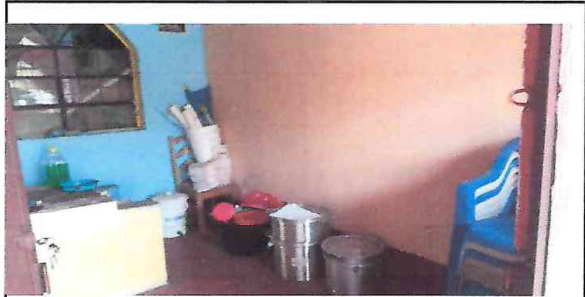
Foto 5. Reparación de cocina, construccion de mesa de concreto.
