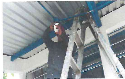
Foto 6. Instalando nuevas plafoneras
