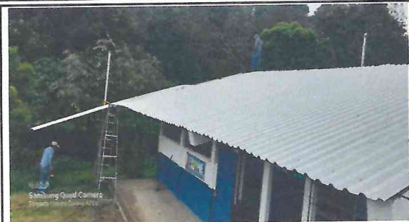
Foto 1 colocando láminas
