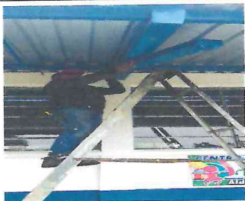
Foto 5. Desinstalando cajas eléctricas viejas
