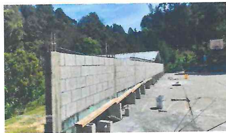
Foto 4. Avance de muro perimetral
