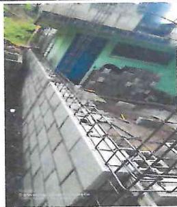
Foto 3. Instalando solera intermedia de muro
