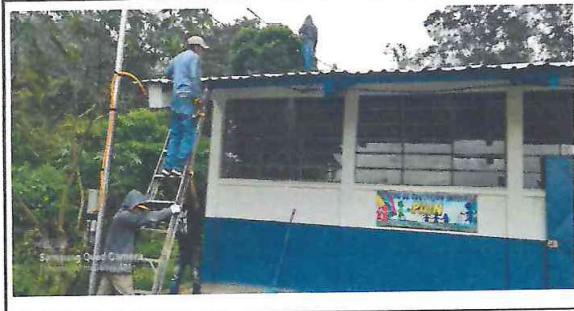
Foto 2. Atornillando láminas
