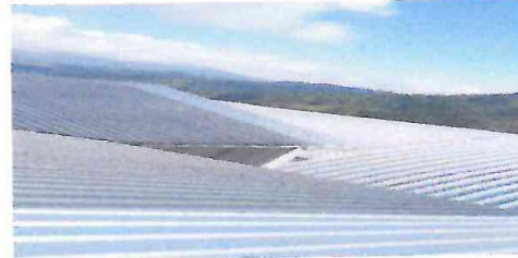
Foto 4: Culminación del cambio de lámina del baño y cambio de tornillos escuela 2.
