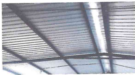
Foto 1: Culminación del techado de los salones de la escuela 1.
