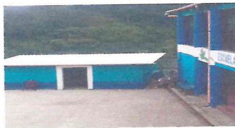
Foto 3: culminación del cambio de techado del salón de educación física escuela 1.
