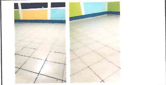
FOTO 1: APLICACIÓN DE CERAMICA COLOR CIMENTO GRIS EN GRADAS Y CORREDOR DE MODULO AULAS
