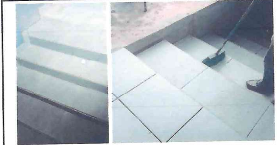
FOTO 2: APLICACIÓN DE CERAMICA EN MODULOS DE AULAS
