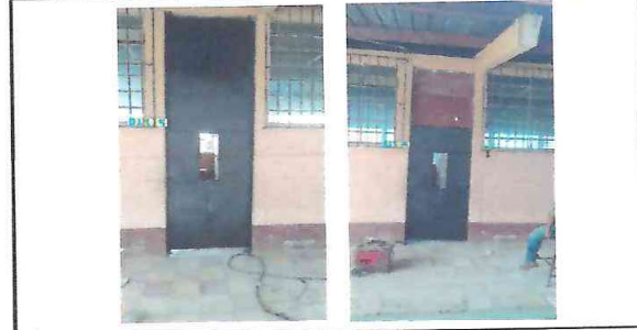
FOTO 4: INSTALACION DE PUERTAS REPARADAS Y PINTADAS
