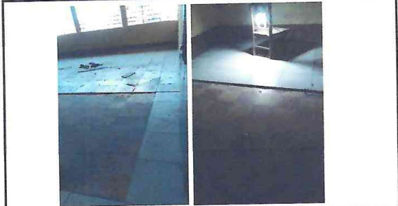
FOTO 2: APLICACIÓN DE CERAMICA EN MODULOS DE AULAS
