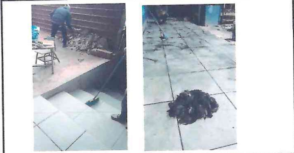
FOTO 1: APLICACIÓN DE CERAMICA COLOR CIMENTO GRIS EN GRADAS Y CORREDOR DE MODULO AULAS
