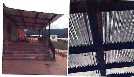
Foto 6: Terminación de colocación de cubierta y barandal de protección.
