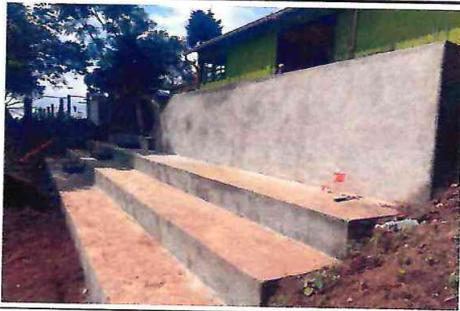
Foto 3: Terminación de muro de contención de block pineado y de columnas reforzados.
