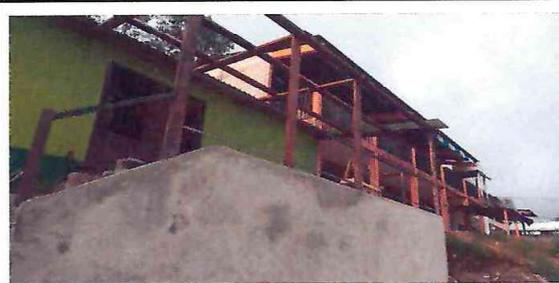
Foto 6: Terminado con trabajos de colocacion de soportes de cubierta de proteccion.
