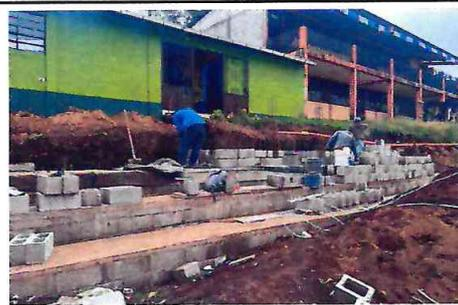
Foto 4: Iniendo con trabajos de colocacion de blocks en modulo de gradas.
