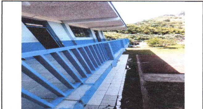
Reparación y mantenimiento de baranda, cambio de barotes, lijar, fondear y pintar.
