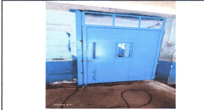
Sustitución de puerta principal del primer nivel.
