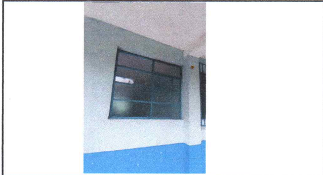
Sustitución de balcones de ventanas de servicio sanitario.
