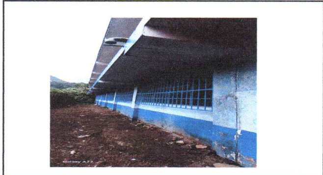
Sustitución de balcones de ventanas del primer nivel.
