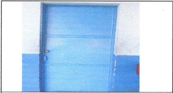
Reparación y mantenimiento de puertas, lijar, fondear y pintar.
