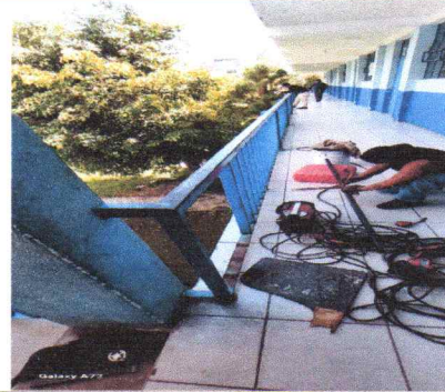
Reparación y mantenimiento de baranda, cambio de barrotos, lijar, fondear y pintar.
