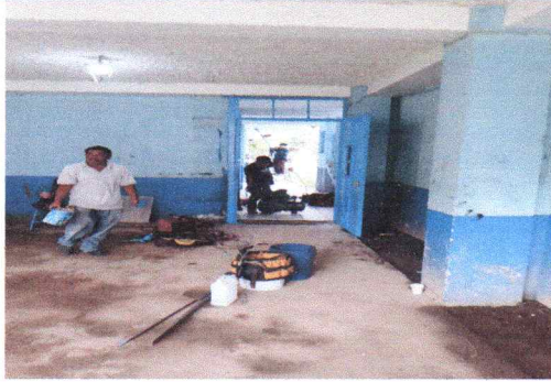
Sustitución de puerta principal del primer nivel.
