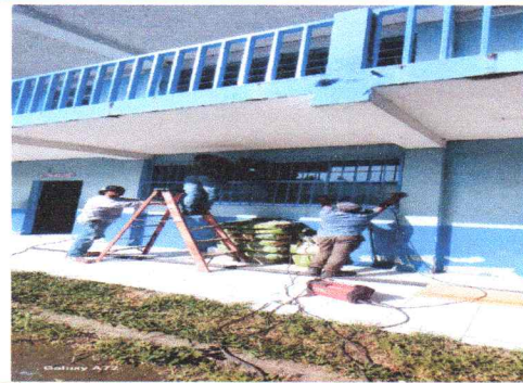
Sustitución de balcones de ventanas del primer nivel.
