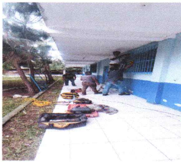
Sustitución de balcones de ventanas de servicio sanitario.
