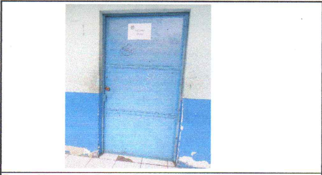
Reparación y mantenimiento de puertas, lijado, fondear y pintar.
