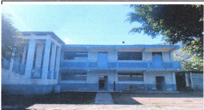
Reparación de baranda segundo nivel.
