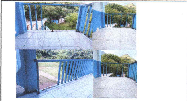
Reparación y mantenimiento de baranda, cambio de barotes, lijado, fondear y pintar.
