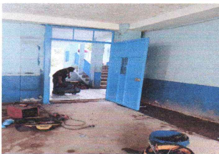
Sustitución de chapas de puestar.
