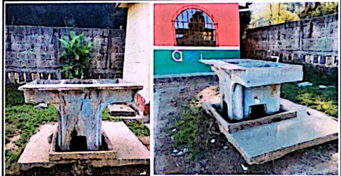
Foto 3: La pila de la escuela ya no esta en condiciones de uso, por lo que se necesita cambiar.
