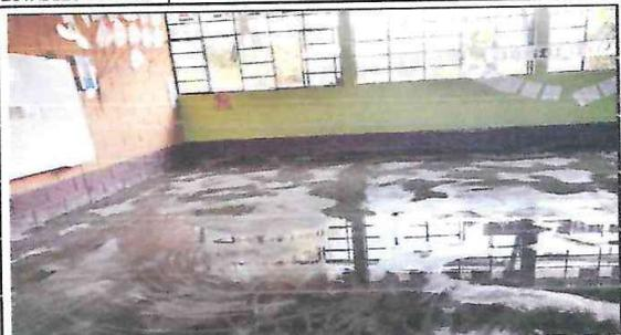
Foto 1 Sustitución de aula de cemento por piso cerámico aula de segundo.
