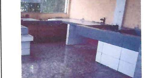
FOTO 2: Terminación de aplicación de cerámica en losa de mesa de concreto y pila.
