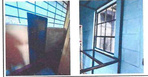
FOTO 6: Terminación de colocación de puertas y ventana.
