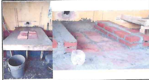
FOTO 2: Elaboración de estructura de comal artesanal.
