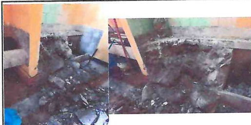
FOTO 5: Trabajos de demolición de concreto ciclopeo
