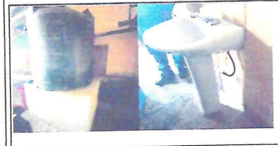
FOTO 5: Deposito de agua deshabilitado por falta de accesorios y lavamanos sin accesorios.
