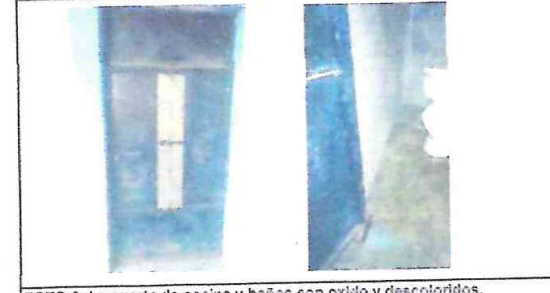
FOTO 6: La puerta de cocina y baños con oxido y descoloridos.
