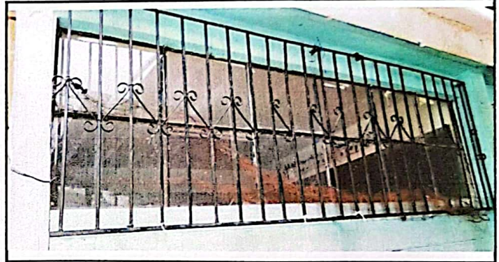
Foto 4: Sustitución de ventanas en mal estado, cierre de ventana por encontrarse en una posición poco funcional
