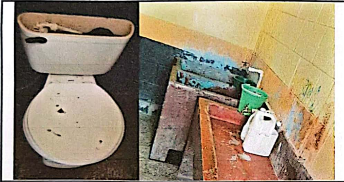
Foto 3: Sustitución de sanitarios y reparación de pila y lavamanos
