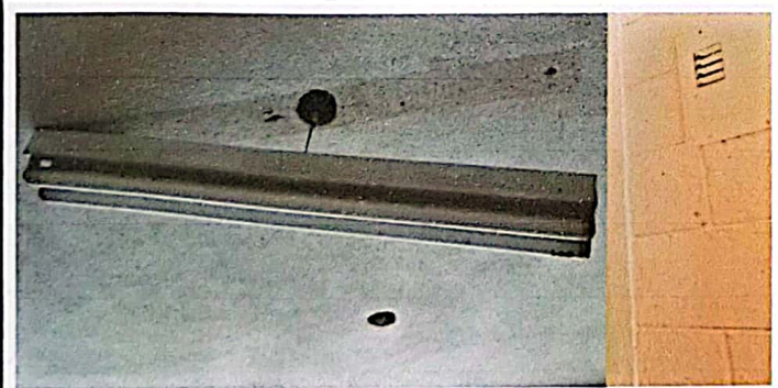
Foto 5: Reparación de sistema eléctrico del establecimiento
