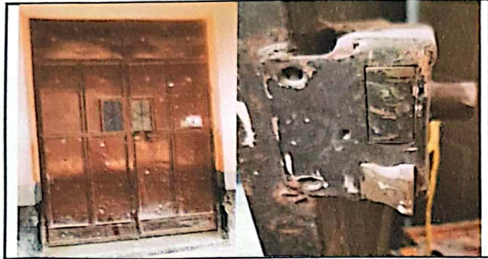
Foto 1: Reparación y mantenimiento a portones y chapas de portones y puertas
