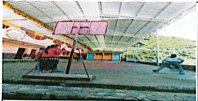
Foto 6: INSTALACIÓN DE ESTRUCTURA METALICA CON COSTANERAS.
