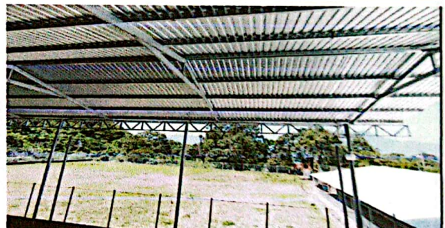
Foto 10: INSTALACIÓN DE COLUMNAS PARA ESTRUCTURA DE METAL EN PATIO.
