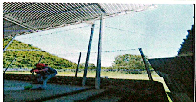
Foto 12: INSTALACIÓN DE JOIS PARA ESTRUCTURA DE TECHO
