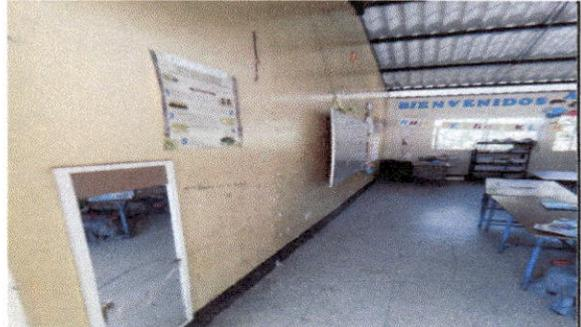
Foto 2: MUROS DE TABLAYESO EN MAL ESTADO SE SUSTITUIRA CON MAMPOSTERIA DE BLOCK
