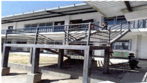
Foto 3: ESTRUCTURA PARA GRADAS CON SIGNOS DE CORROSIÓN
