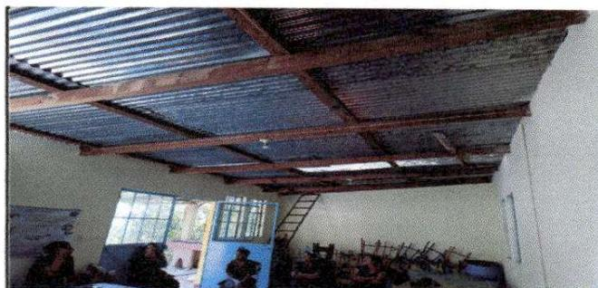
Foto 12: LAMINA LEVANTADA Y CON FILTRACIONES
