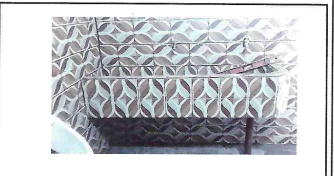
Foto 6: Remodelación de lavamanos.
