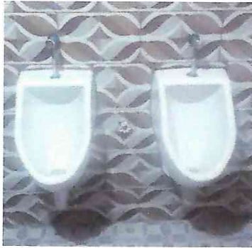
Foto 6: Cambio de llaves de mingitorios.
