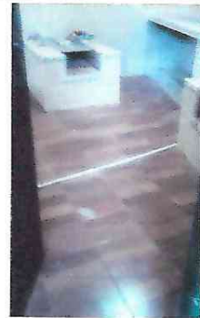
Foto 7: Colocaciónn de piso cerámico.
