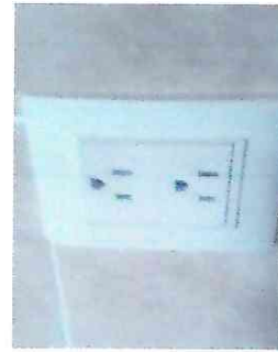
Foto 10: Cambio de tomacorriente
