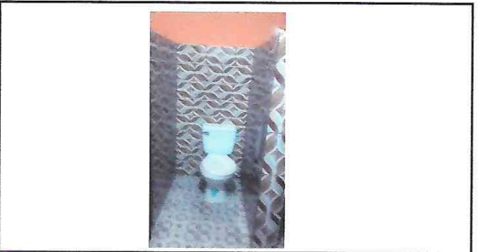
Foto 5: Remodelación de sanitarios.
