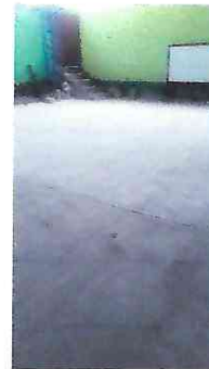
Foto 12: Remodelación losa de patio.
