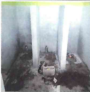
Foto 5: Reparación de sanitarios.
