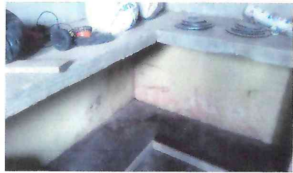
Foto 4: Reparación de gabinetes.
