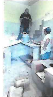
Foto 8: Colocación de piso cerámico.
