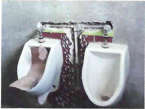
Foto 7: Cambio de llaves de mingitorios.
