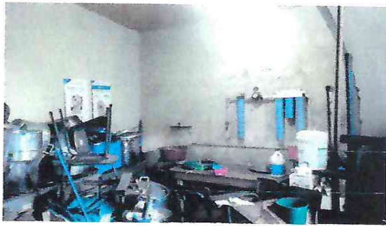
Foto 15: Pintura en mal estado.
