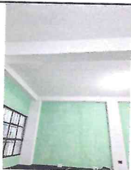
Foto 3: Culminación de techo interior ✓
