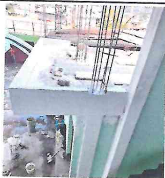
Foto 1: terminación de techo ✓
