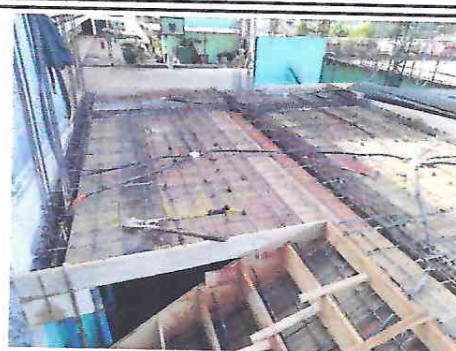
Foto 2: Estructuración de techo ✓
