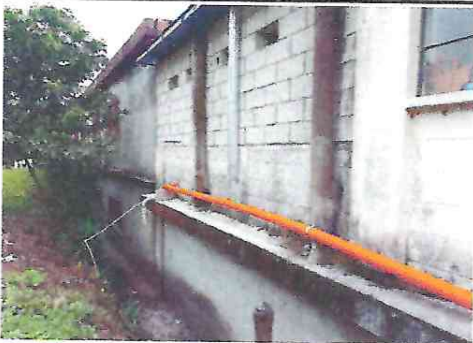
Foto 5. Línea de aguas negras reparada.
