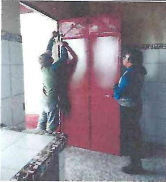
Foto 1. Reparando puerta por aumento de nivel de piso dentro de la cocina
