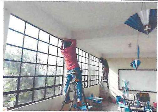
Foto 2. Cambiando cortineras de metal por cortineras de madera en mal estado
