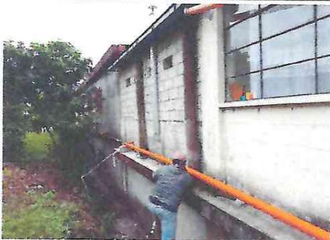
Foto 5. Reparando línea de aguas negras en mal estado
