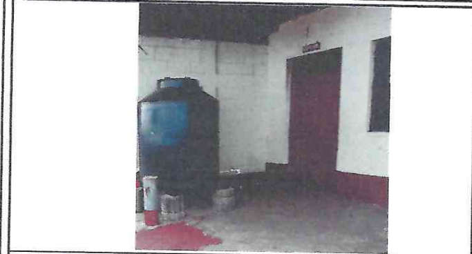
Foto 1: Reparación de puerta por aumento de nivel de piso dentro de la cocina
