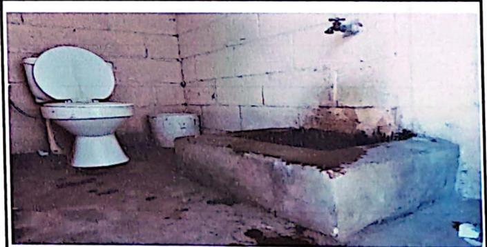
Foto 4: Tazas deteriorado y mengitorio inadecuado.
