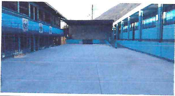
Foto 3: Fundición de losa de patio
