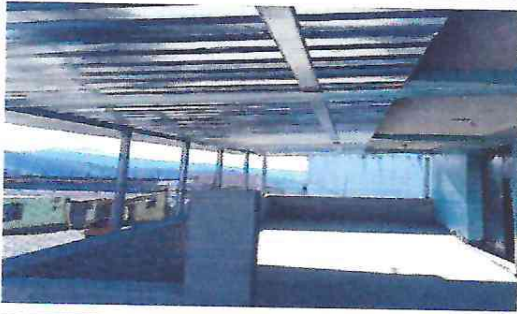
Foto 1: Levantado de muro perimetral, colocación de techo, maya y losa en el area.
