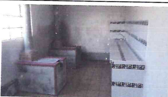
Foto 5: Remodelación de cocina, colocación de piso, elaboración de gabinete, azulejeado, repello y cernido.
