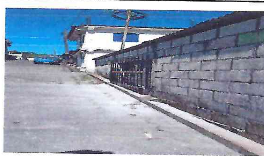
Foto 4: Colocación de balcon en la ventana.
