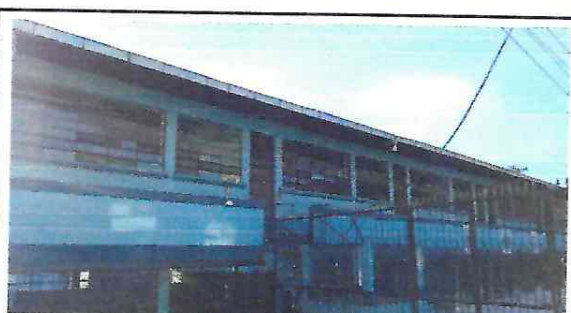
Foto 6: Instalación y corrección de cables positivo y negativo del sistema eléctrico
