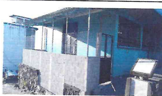
Foto 2: Colocación de muro perimetral, techo, instalación de maya y puerta en el area de preprimaria.
