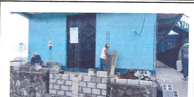
Foto 2: Relleno y levantado de muro perimetral por el mal estado y evitar el peligro de acceso de los niños.
