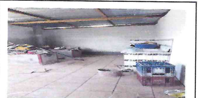
Foto 5: Remodelacion de cocina, colocación de piso, elaboración de gabinete, azulejado, repello y cernido.
