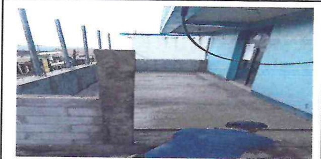
Foto 1: Por el mal estado del espacio se demolieron las gradas se reparo colocando fundición de losa, levantado de pared
