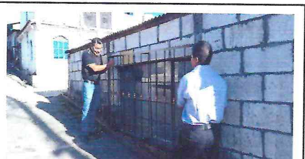
Foto 4: Colocación de balcon en la ventana.
