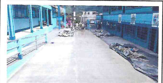
Foto 3: Fundición de losa de patio
