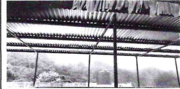
Sustitución de Láminas
