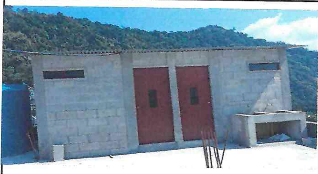
Finalización de cambio de láminas
