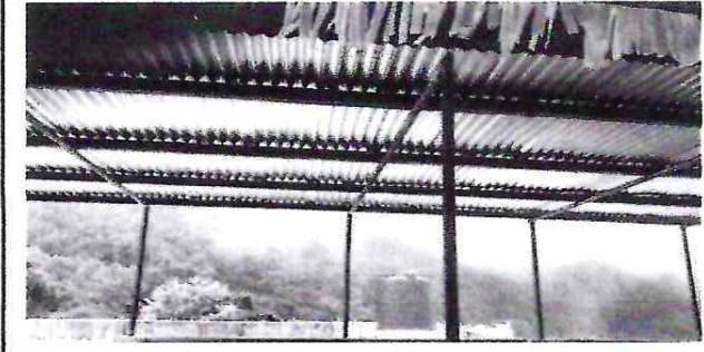
Sustitución de Láminas
