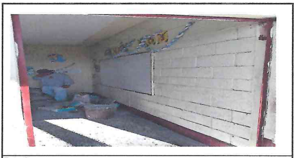
Foto 6: reparando y pintando puertas
