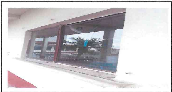
Foto 4: reparación y pintada de balcones
