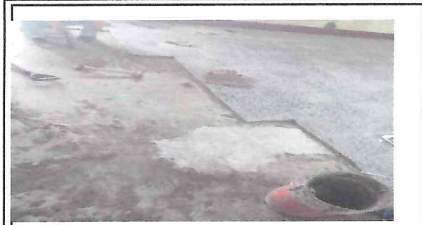
Foto 1: Colocación de piso en las aulas
