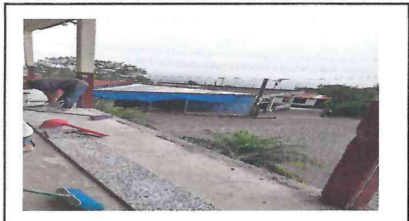
Foto 2: colocación de pisos en el corredor
