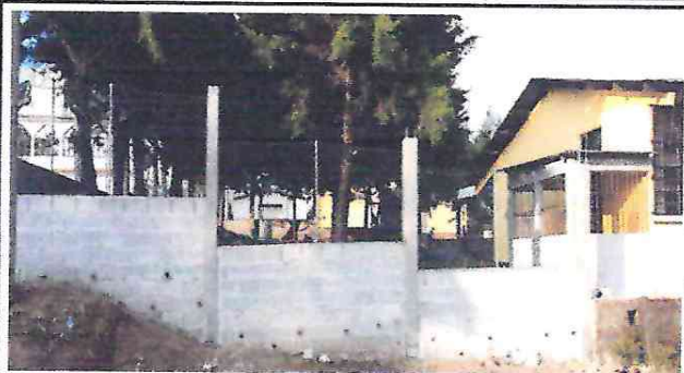
Foto 1: Circulación finalizada lado sur
