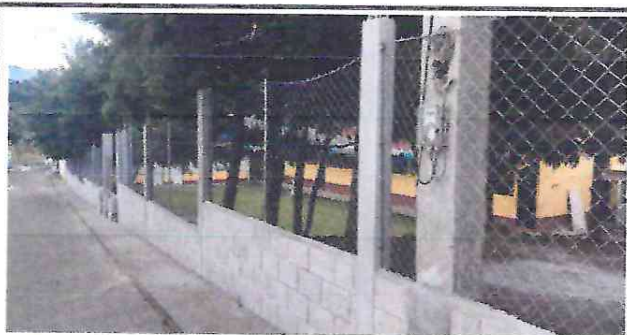
Foto 3: Circulación finalizada vista desde frente de la escuela.
