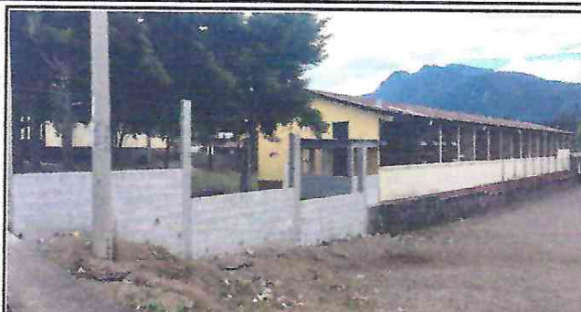
Foto 2: Circulación y colocación de malla terminada.
