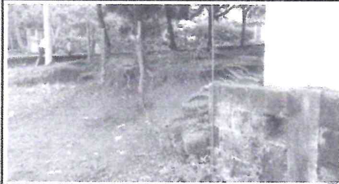
Foto 1: Circulación del Centro Educativo en mal estado.
