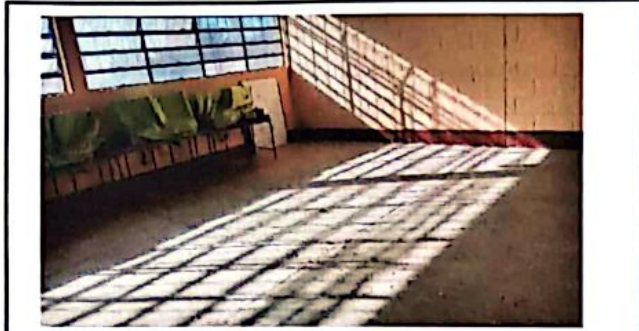
Foto1: 6.7 sustitucion de piso
