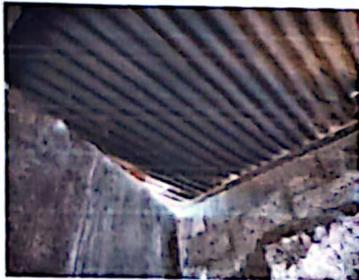
FOTO 1: Sustitución de soporte de madera por metal área cocina
