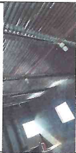
Foto 5: COLOCACION DE TECHO FINALIZADO
