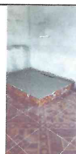
Foto 4: PLATAFORMA PARA COLOCACIÓN DE PILA, FINALIZADA
