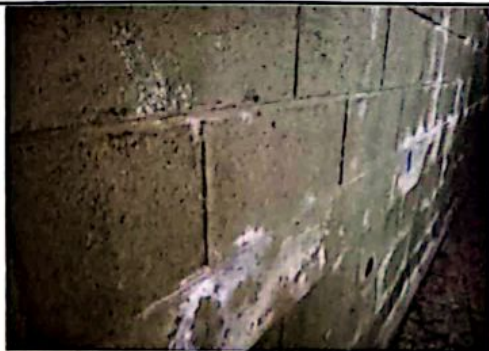
Foto 5: Aplicación de impermeabilizante
