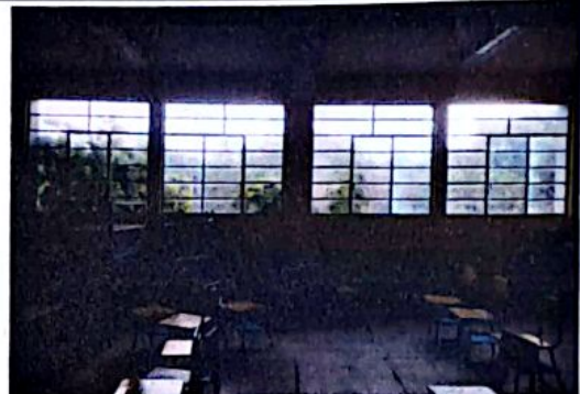
Foto 4: Ventanales lado sur aula de primero y segundo grado
