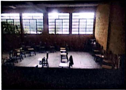
Foto 1: Ventanales del lado sur aula preprimaria
