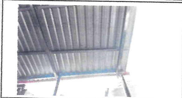
Foto 1: Techo de la pila armada.
